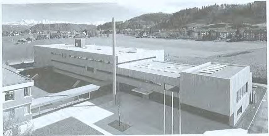
Die METAS-Erweiterungsbauten in Wabern schaffen die Voraussetzungen und die nötige Laborinfrastruktur für Dienstleistungen und Messungen höchster Genauigkeit für den Industrie- und Technologiestandort Schweiz.
